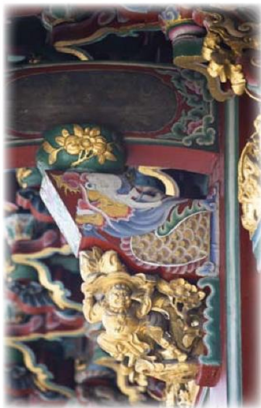
▲ 斗拱頂住大屋架，承受穩定及傳遞屋頂的重量。
