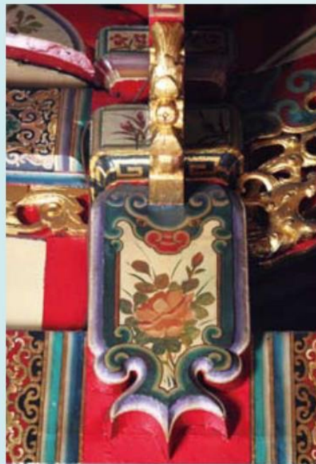
▲ 瓜柱作成方形斷面下端雕成鼻頭狀，有稱「方筒」。
