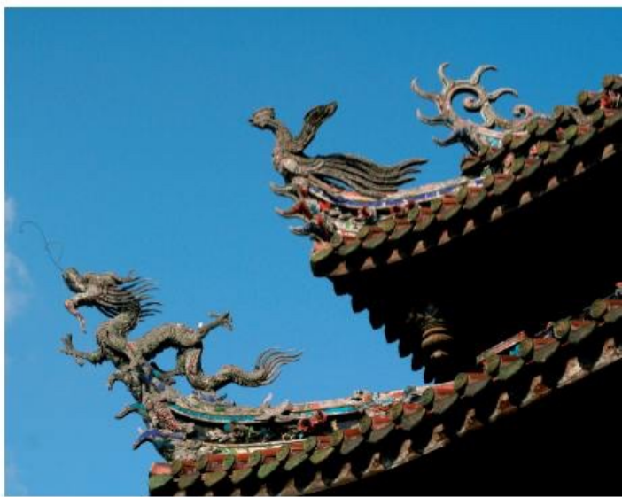
▲ 玻璃材料剪黏因無法承受長年日曬雨淋而剝落。
