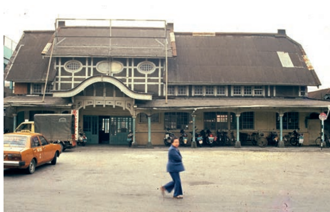
民國七十五年木構造的萬華車站拆除，後配合萬板專案進行改建，在鐵路地下化之後，現狀東、西兩棟萬華車站新站正式啟用。（駱金威提供）
