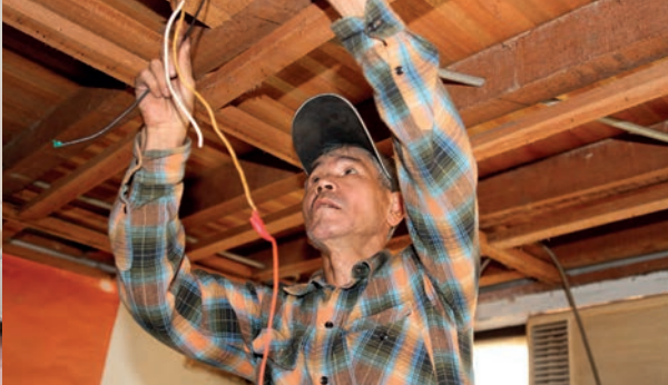
起家工作室：面對弱勢家戶老舊的線路，水電師傅仔細地檢查並汰換，以確保居家安全。
