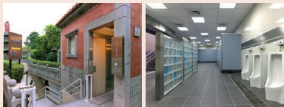
龍山寺公廁經簡副董長公司大力協助改建為新穎、乾淨、富現代化之地下化建築，並經環保署膺選為特優級榮譽公廁。
