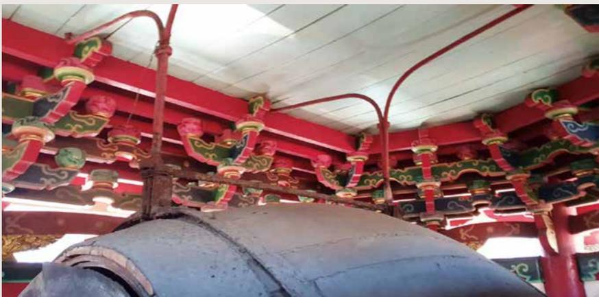
• 鼓上的金屬支架示意圖。但大鼓搬遷拆卸時發現支架鏽蝕嚴重，無法拆解，因此只能將其鋸開。（圖片提供：黃明毅）
